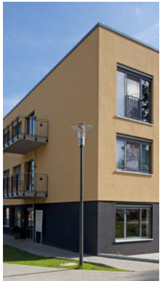
Asklepios Westklinikum Rissen, DE-Hamburg Architect: APB. Architekten BDA, DE-Hamburg
